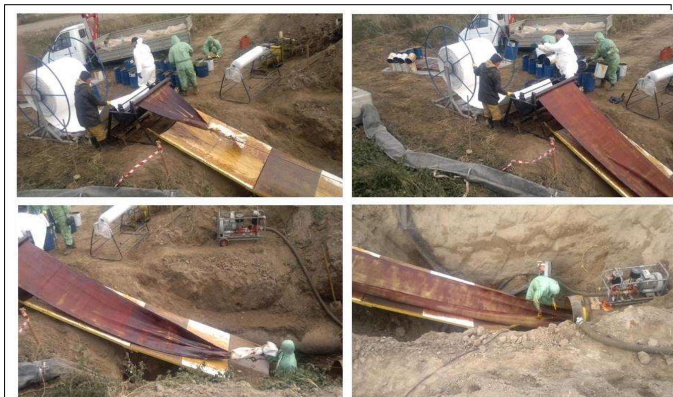
Р Пропитка рукава полимерным составом в процессе ввода в трубопровод одновременной пропиткой рукава полимерным составом
