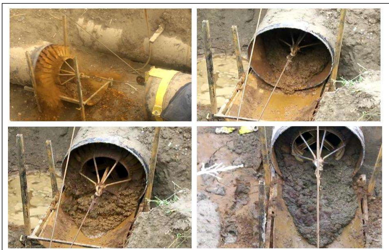
Механическая очистка скребком «Доркомтехника» Рисунок 7. Очистка внутренней поверхности трубопровода скребками
