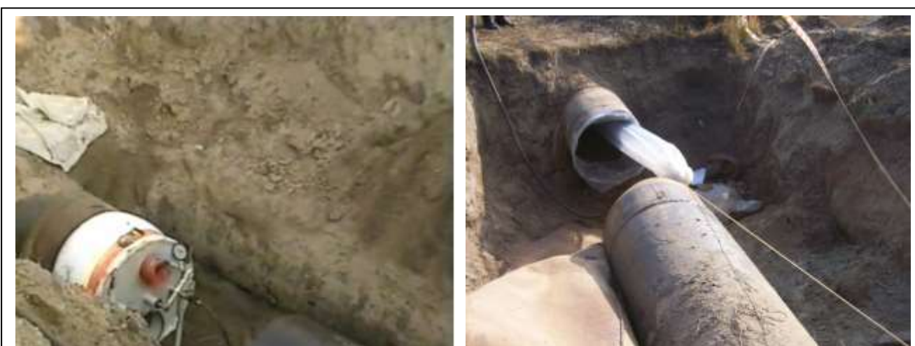
Рисунок 20. Фрагменты выдержки рукава под давлением и удаление полиэтиленового рукава после полимеризации клея.
