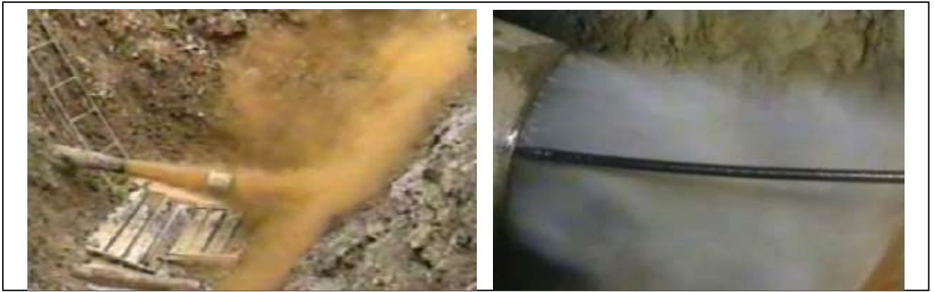
Рисунок 8. Обеспыливание внутренней поверхности трубопровода
