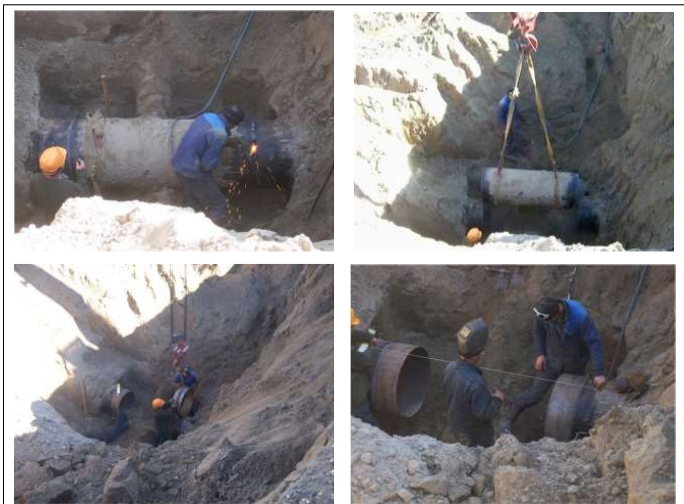
Рисунок 2. Вырезка катушек и врезка колец по трассе восстанавливаемого трубопровода
