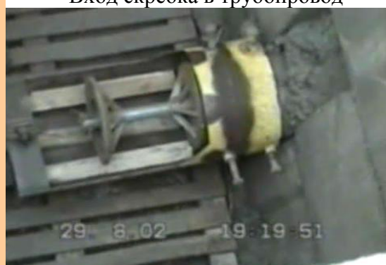
Вход поршня в трубопровод
