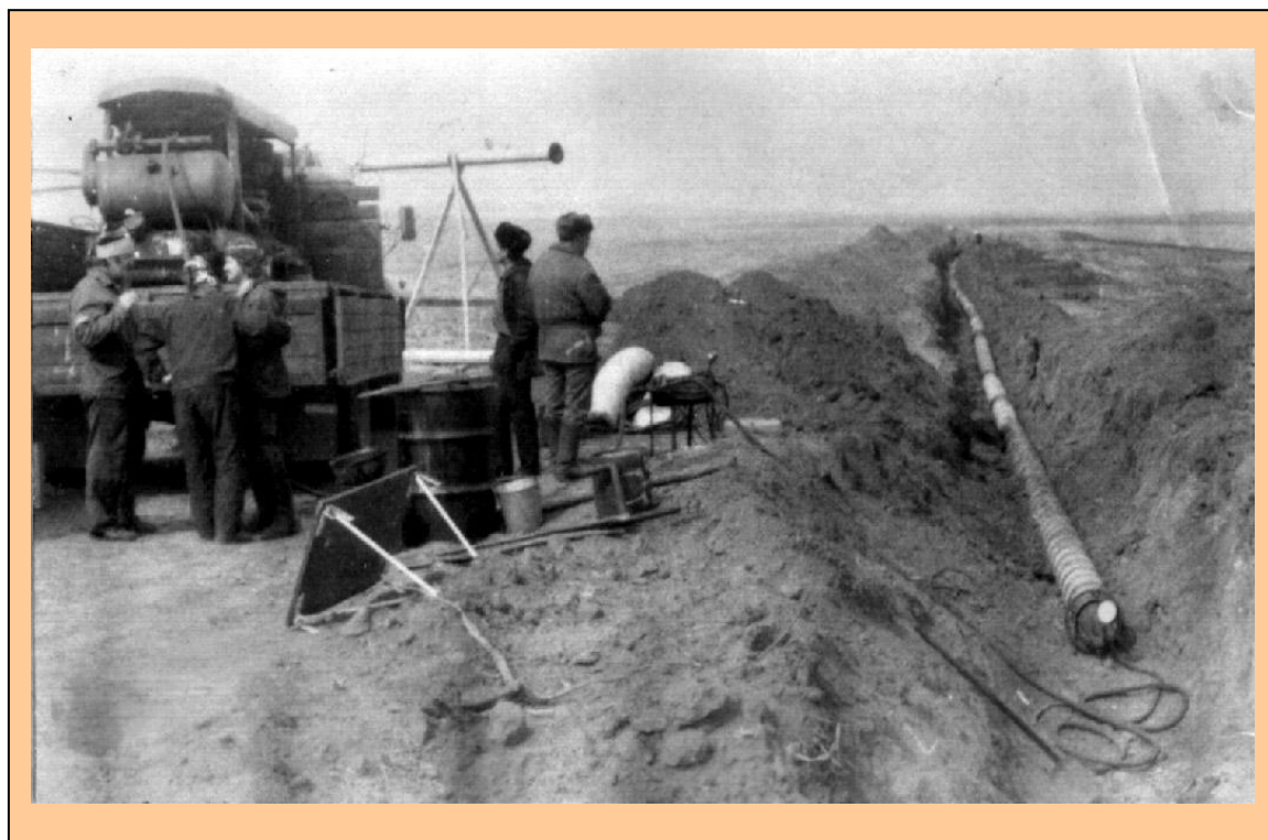
Рис. 3.35. Фрагмент изолируемого участка трубопровода D_y 300мм, длиной 700 метров на Шебаевской оросительной системе
