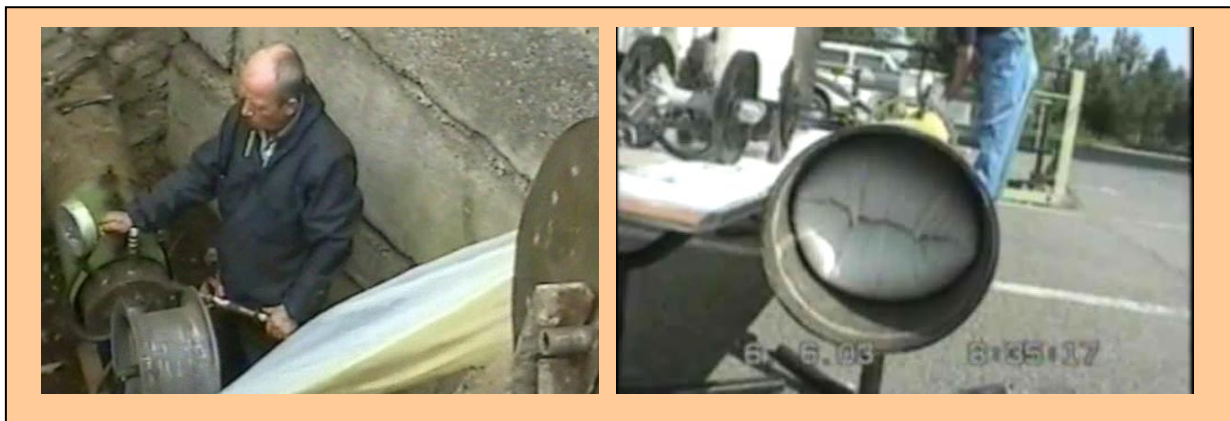
Рис. 4.24. Фрагменты ввода комбинированного рукава в трубопровод с выворотом через пневмозатвор под давлением
