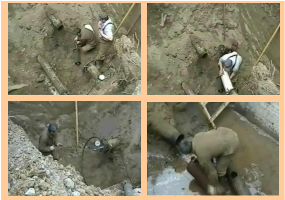
Рис. 2.3. Фотофрагменты вытеснения остатков воды из трубопровода и протаскивания каната с помощью тора-разделителя
