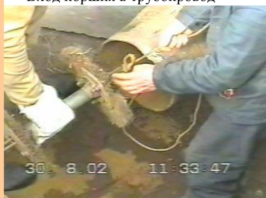
Установка щетки для обеспыливания
