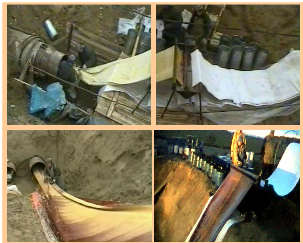
Рис. 4.28. Фрагменты ввода комбинированного рукава в трубопровод без выворота с одновременной пропиткой рукава полимерным составом
