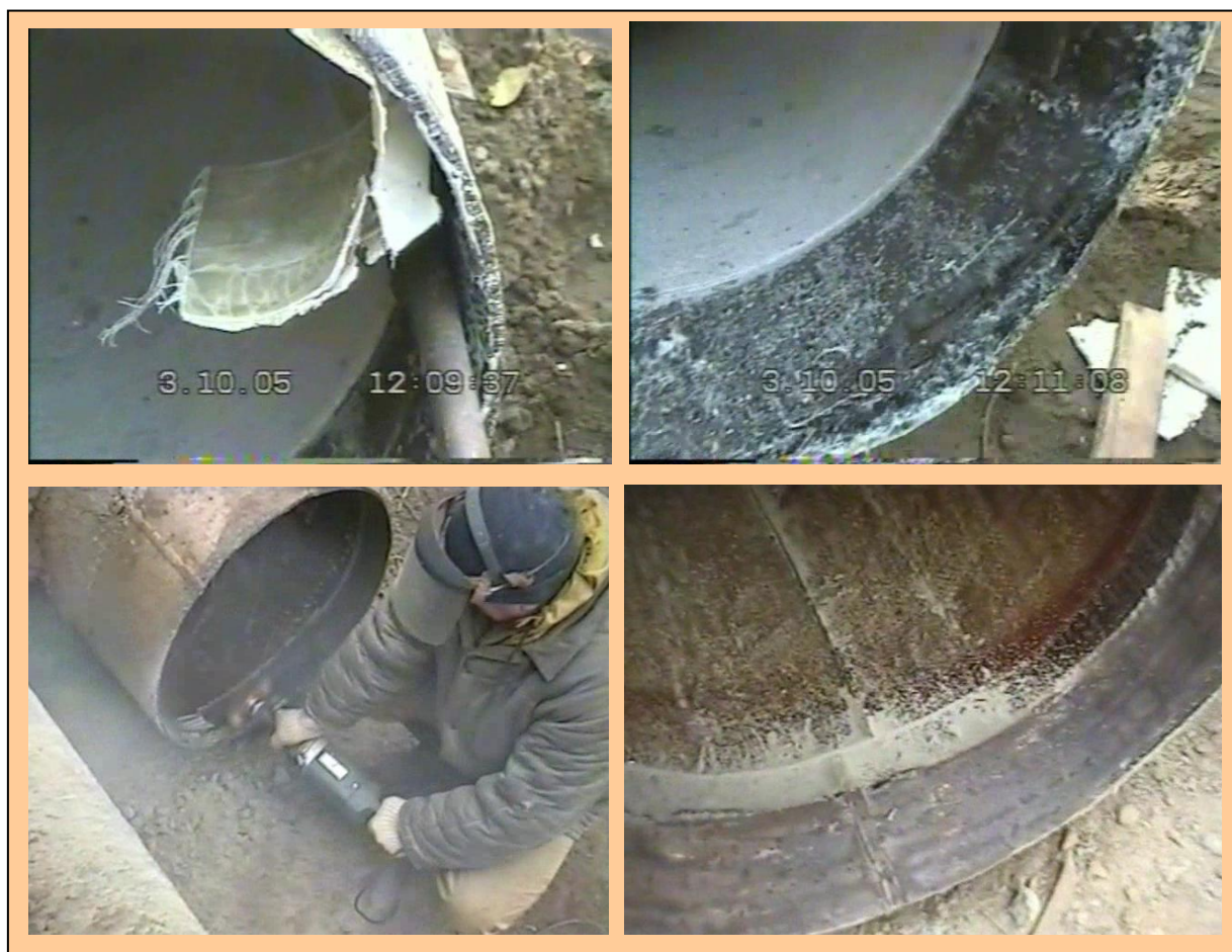
Рис. 4.35. Очистка концов восстановленных труб под сварку
