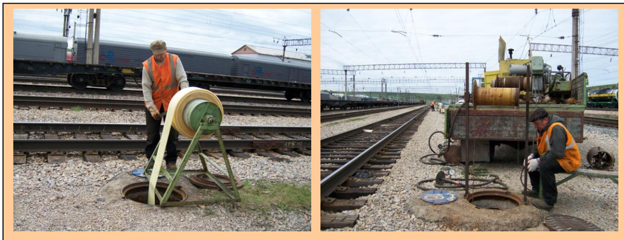
Рис. 4.29. Ввод комбинированного рукава без выворота с предварительной пропиткой тканевой оболочки полимерным составом
