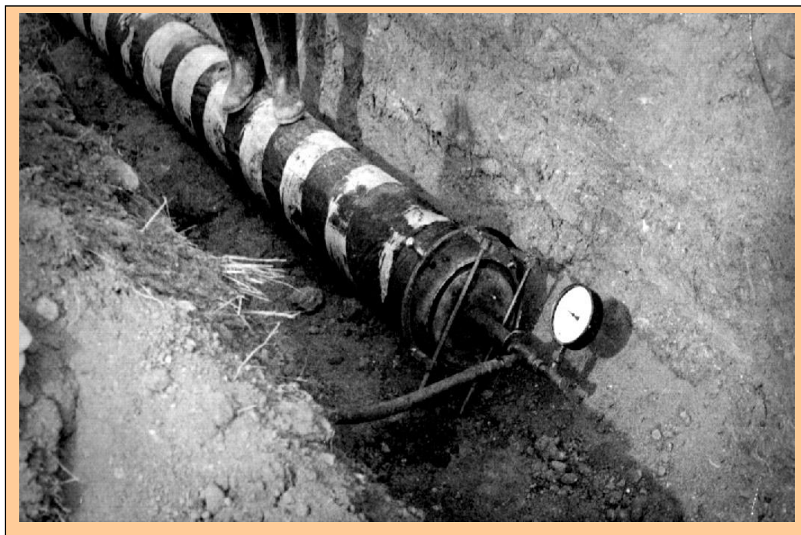
Рис. 3.34. Подача воздуха в трубопровод для перемещения торов и состава
