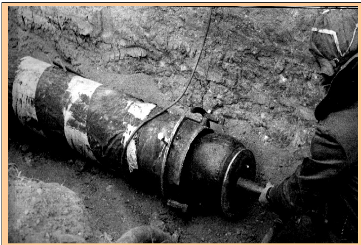
Рис. 3.33. Установка заглушки с тором-уплотнителем
