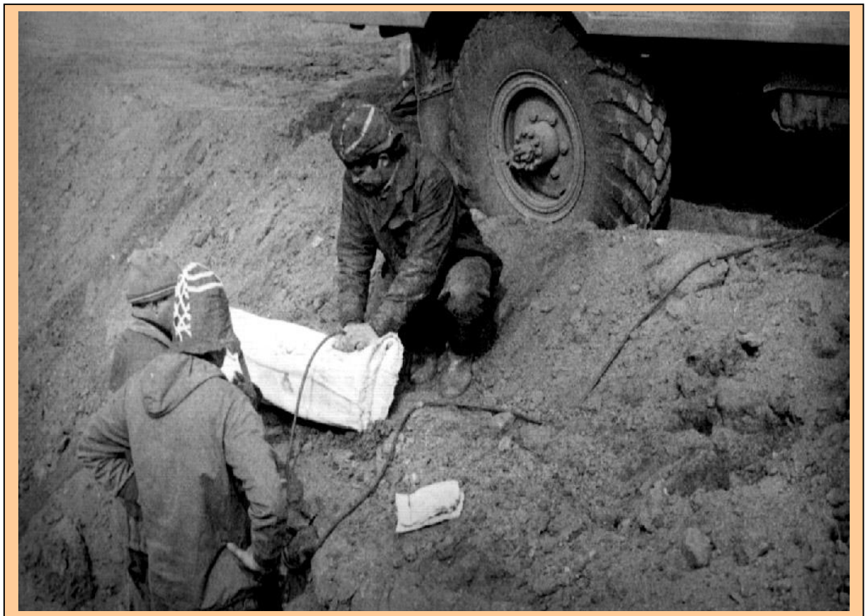
Рис. 3.30. Подготовка торов-разделителей
