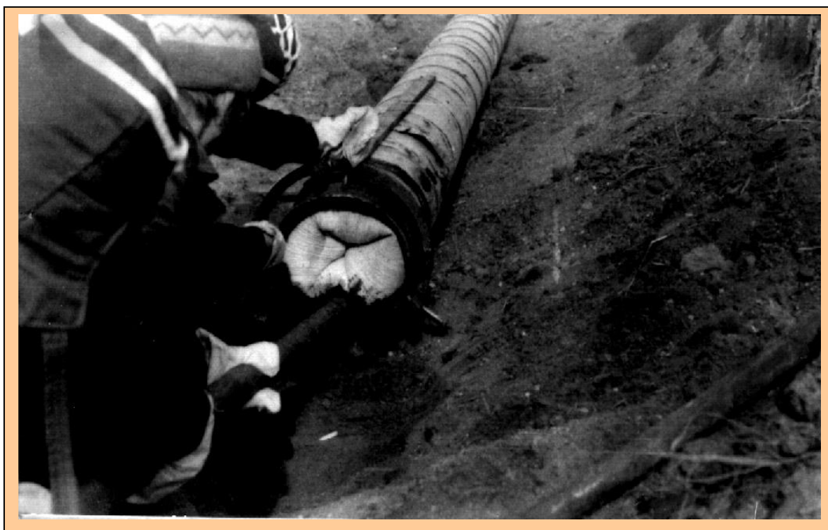
Рис. 3.32. Установка торов-разделителей в исходное положение
