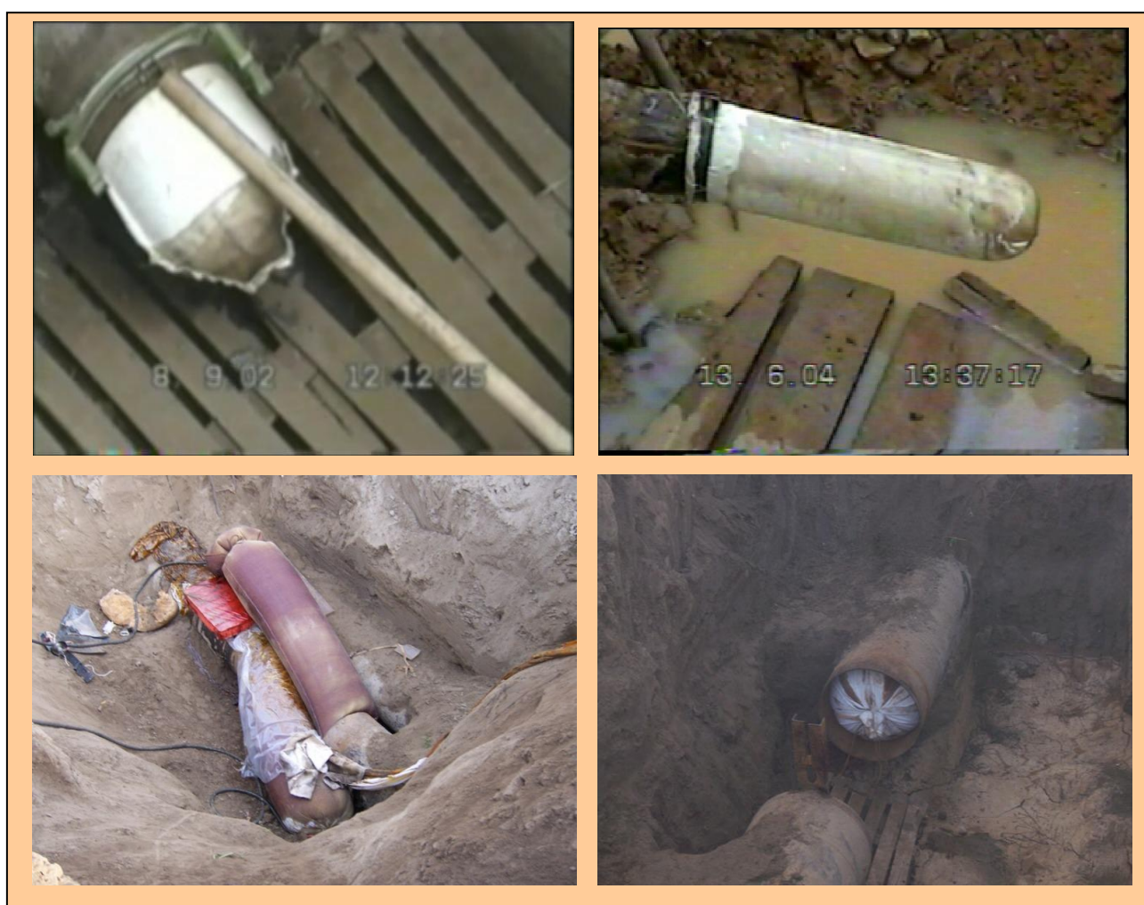
Рис. 4.33. Фрагменты выдержки введенного рукава под давлением
