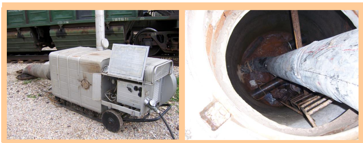
Рис. 2.11. Продувка трубопровода подогревателем воздуха 8Г27К
