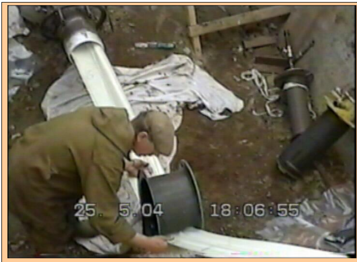
Рис 4.27. Фотофрагмент ввода комбинированного рукава в трубопровод с выворотом под вакуумом
