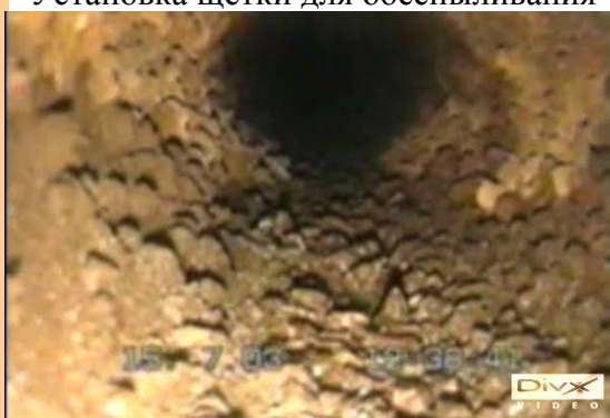
Состояние трубопровода до очистки
