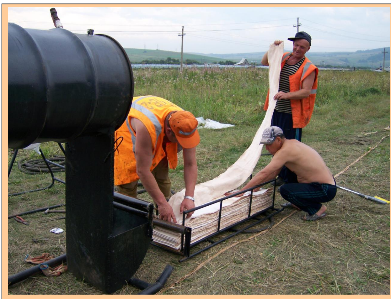
Рис. 4.11. Укладка тканевого рукава в кассету
