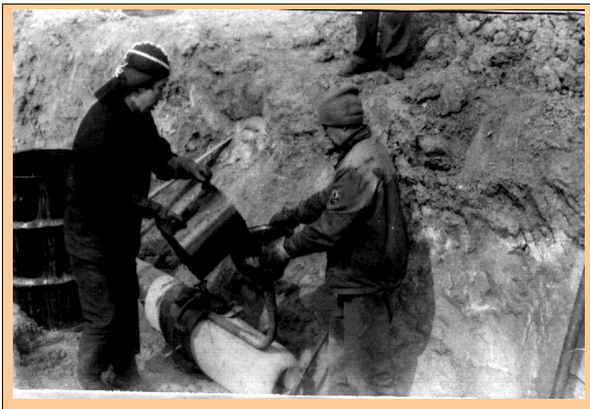
Рис. 3.31. Заливка защитного состава между торами-разделителями (вариант 2)
