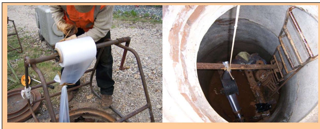
Рис. 4.30. Фрагменты ввода полиэтиленового рукава с выворотом внутрь тканевой оболочки при восстановлении трубопровода
